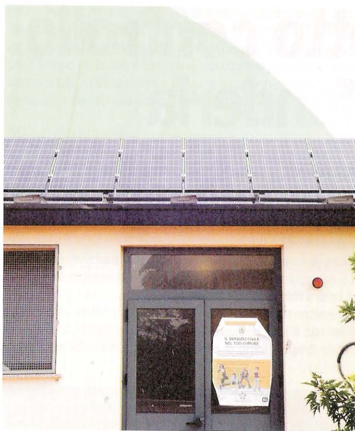
SUBCAMPO Ogni subcampo è costituito da 48 moduli che sviluppano 6000W/p e sono dotati di inverter Fronius modello IG60. Ogni modulo ha diodi di by pass, ogni stringa ha diodi di blocco, i moduli sono collegati con cavi Multi Contact
