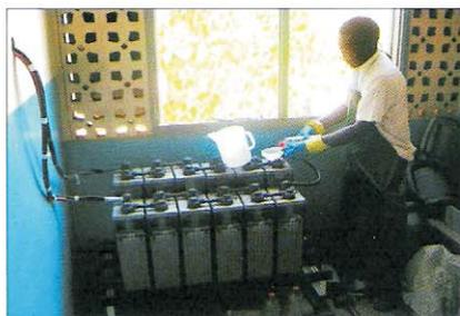
Le batterie : il riempimento con l'elettrolita
