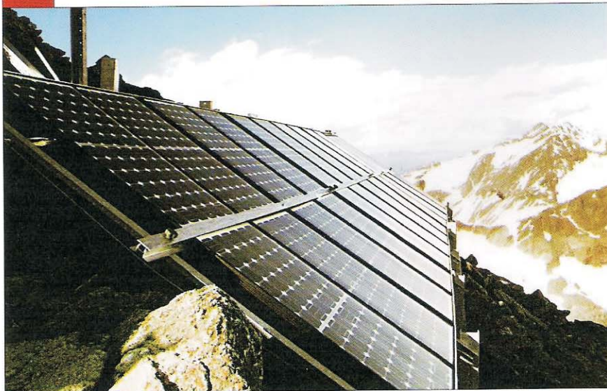
Sistema fotovoltaico stand-alone del rifugio Biasi.
