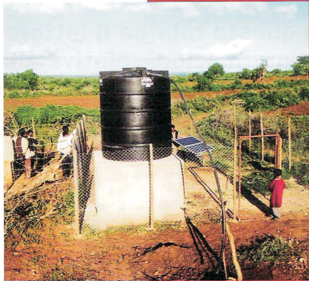
Mana Sodda (Etiopia), SISTEMA SWP installato da Sasso srl di Cuneo. L'impianto assicura il fabbisogno di acqua potabile per una comunità di 600 persone, con 30 m 3 /giorno di acqua pompata.
