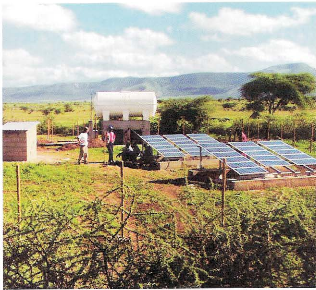
Mana Sodda (Etiopia), SISTEMA SWP installato da Sasso srl di Cuneo. L'impianto assicura il fabbisogno di acqua potabile per una comunità di 600 persone, con 30 m 3 /giorno di acqua pompata.
