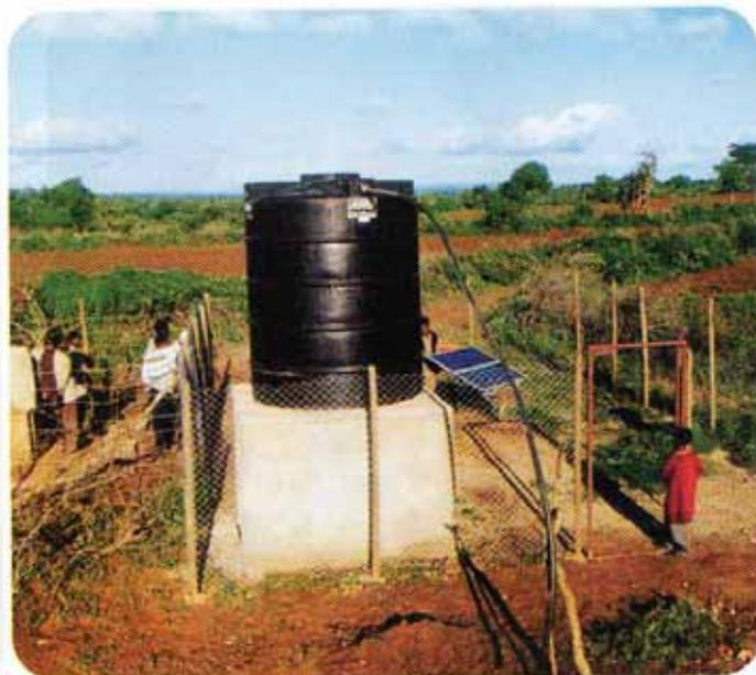
Mana Sodda (Etiopia). Sistema SWP installato da Sasso srl di Cuneo. L'impianto solare assicura il fabbisogno di acqua potabile per una comunità isolata di 600 persone, con 30 m<sup>3</sup> di acqua pompata al giorno.
