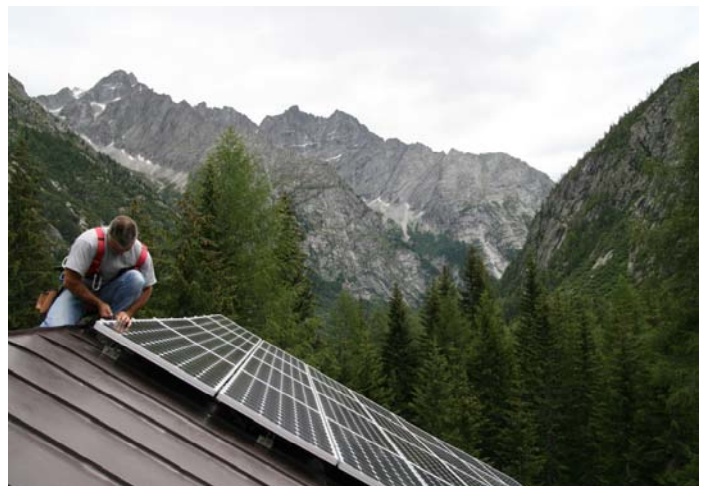
Installazione dei moduli fotovoltaici
