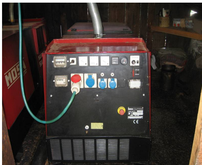
Particolari del generatore Diesel da 30kW
