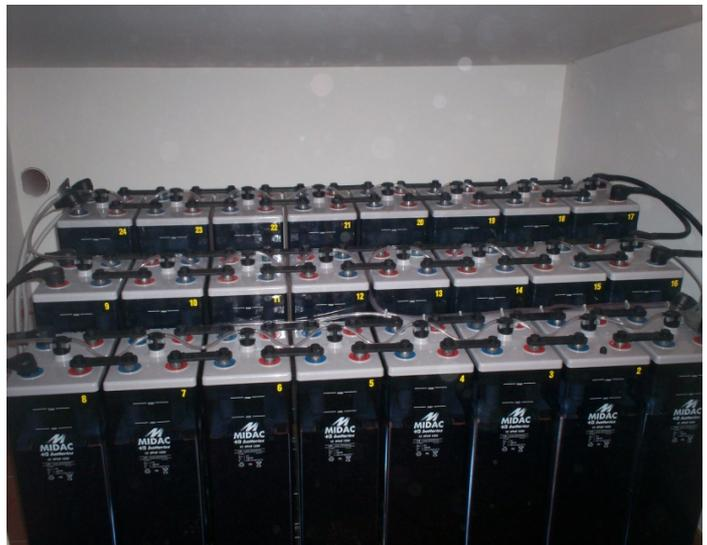
Particolare delle batterie e del sistema tappi a "sfiato esterno"
