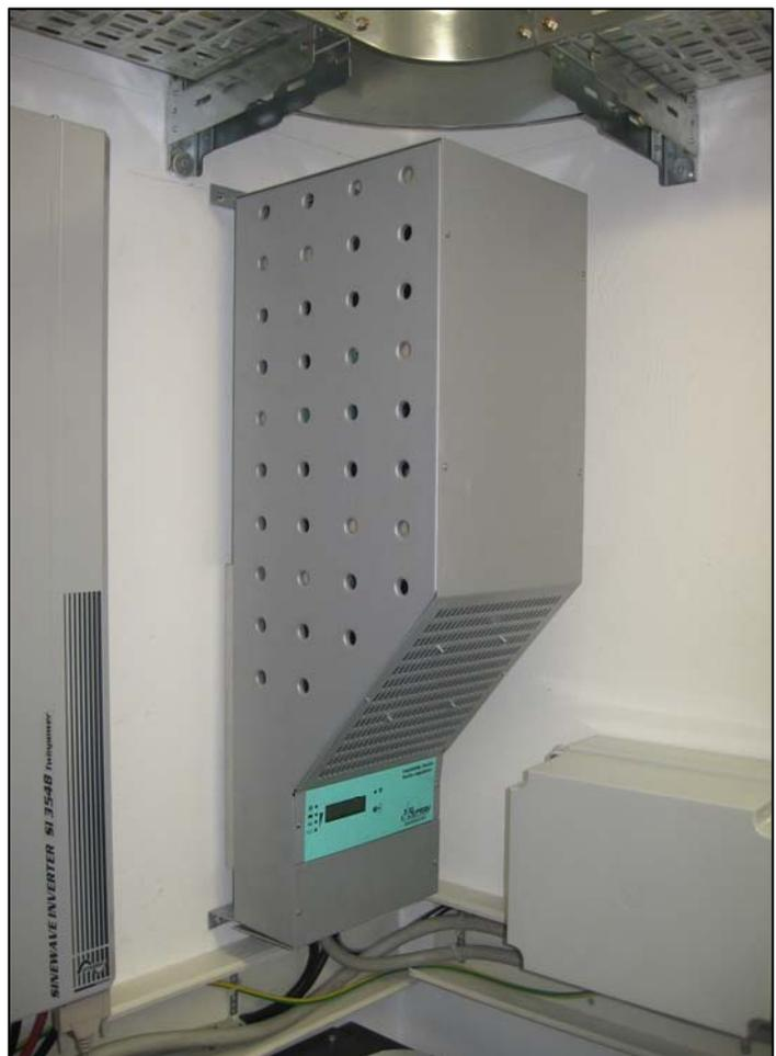
Particolare convertitore DIGITALE e controllo Generatore Eolico PWW
