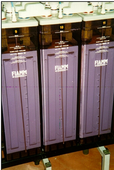
ESEMPIO DI SALA BATTERIE (FIAMM SPA) COMPLETE DI SISTEMA DI ANTISTRATIFICAZIONE (TUBI BLU)
