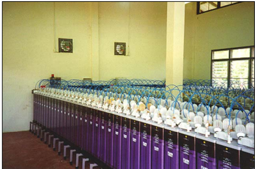
ESEMPIO DI SALA BATTERIE (FIAMM SPA) COMPLETE DI SISTEMA DI ANTISTRATIFICAZIONE (TUBI BLU)
