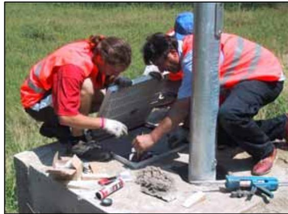
N.B. In questa fase viene inoltre fissato il collegamento RS232 all'interno dell'asola del palo. Questo cablaggio verrà inoltre protetto con un capolino plastico stagno e uno sportello con guarnizione adatto all'asola del palo stesso.
