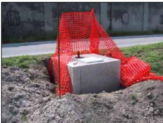
N.B. Il plinto è stato calcolato per i coefficienti di pressione terreno, peso del lampione fotovoltaico e ventosità del posto. Come da progetto è stata inserita una gabbia armata prima del getto , la quale fa anche da base per il fissaggio del pozzetto plastico di contenimento delle batterie.
